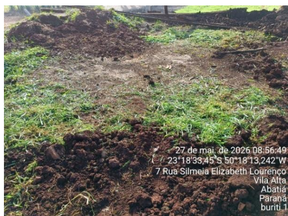
Figura 02 – Fossa do Buriti I devidamente tampada
