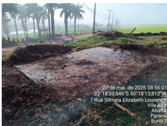
Figura 01 – Fossa do Buriti I devidamente tampada
