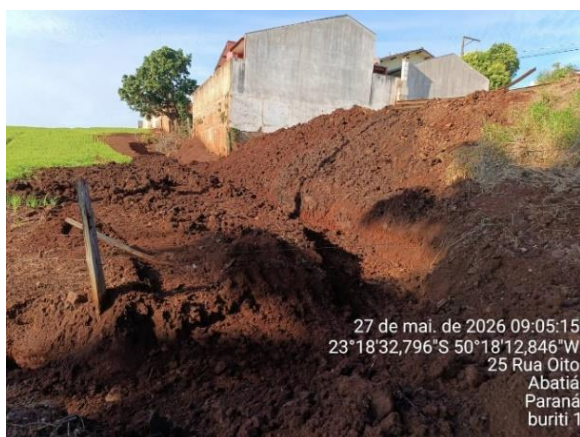
Figura 06 – Área de escoamento pontual de lodo no Buriti I
