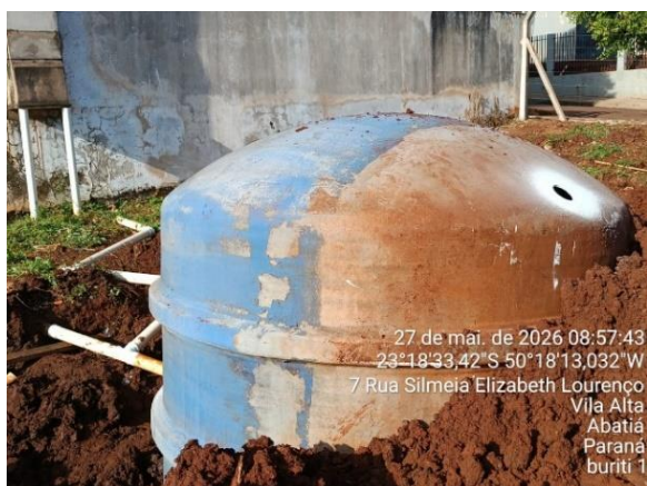
Figura 03 – Fossa do Buriti I devidamente tampada
