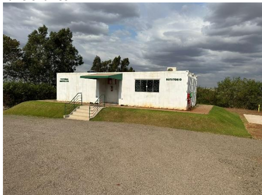
Imagem 22 – Refeitório e vestiário para uso dos funcionários
