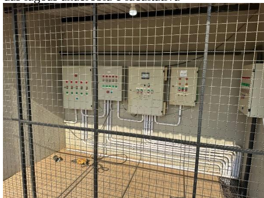
Imagem 30 - Quadro de comando de equipamentos das lagoas anaeróbia e facultativa
