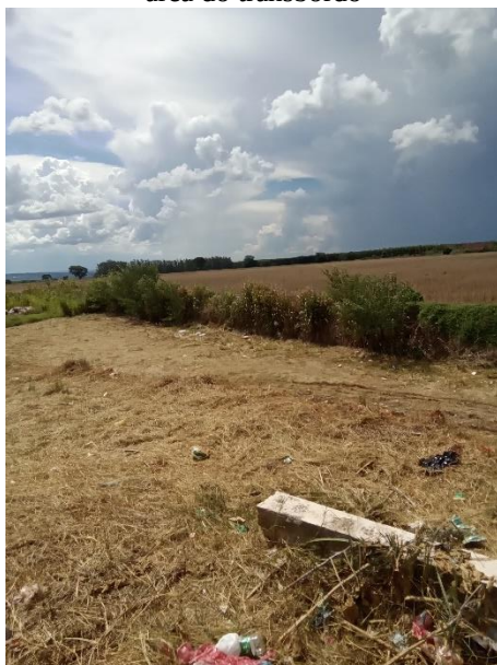
Imagem 14 – Excesso de vegetação no alambrado do entorno do isolamento da área do transbordo
