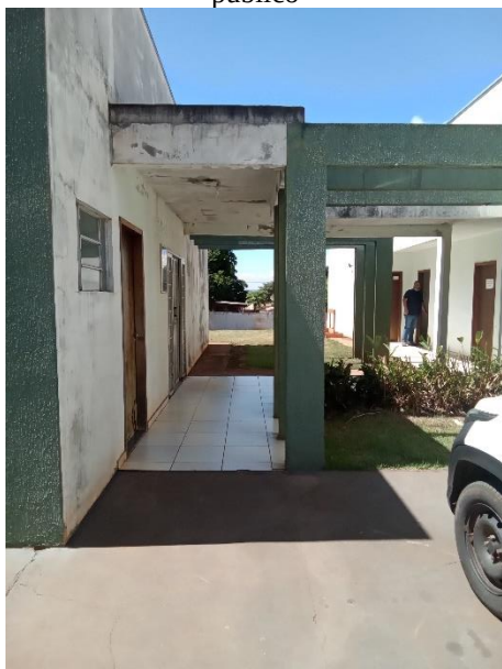
Imagem 1 – Acesso principal ao atendimento ao público
