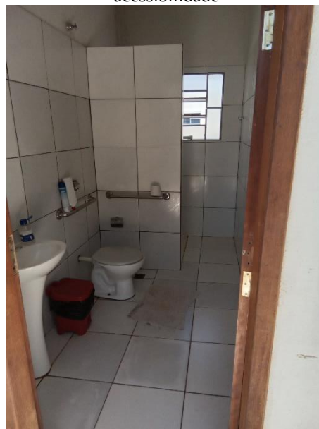
Imagem 6 – Sanitário de acesso ao público com acessibilidade
